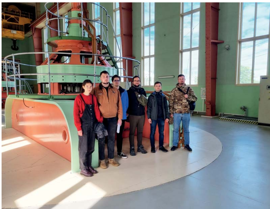
Studenci i prowadzący z Wydziału Elektrycznego Politechniki Warszawskiej w hali maszynowni ESP Dychów
