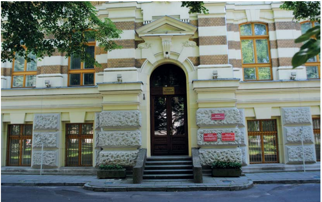
Wejście główne do Gmachu Mechaniki –siedziby dyrekcji Instytutu Elektroenergetyki | Podpis
