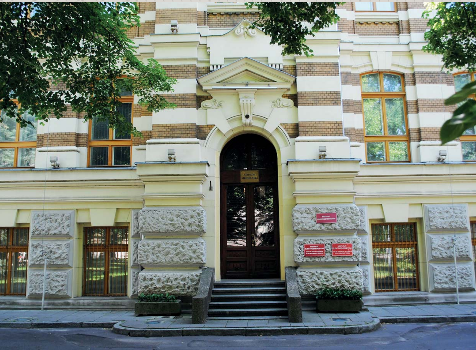
Wejście główne do Gmachu Mechaniki – siedziby dyrekcji Instytutu Elektroenergetyki
